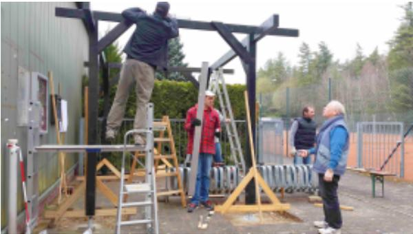
Das aller wichtigste kam dann am Ostersonntag (26. März) ab 9:00 Uhr, der Aufbau des kompletten Unterstandes. Am Donnerstag vorher habe ich schon ein paar Löcher für die Stützanker gebohrt, die Stützanker an die Stützen geschraubt und das Dach auf die richtige Länge zugeschnitten.
